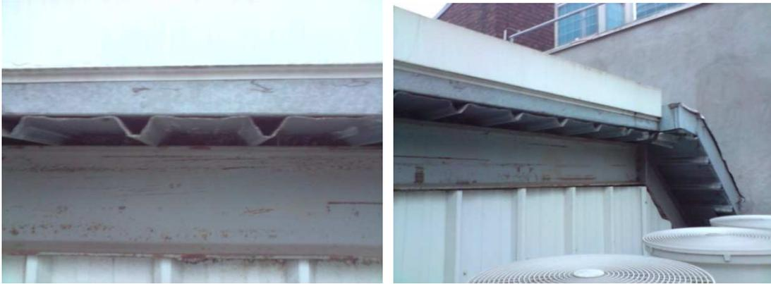
Nous avons remarqué qu'il y avait de grosses déperditions thermiques au niveau de cette jonction entre la toiture et le mur.
